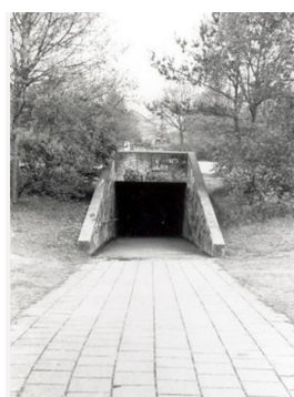
Foto fietstunnel Ruwaardsingel. Aangelegd in 1973. Momenteel in gebruik als verblijf- plaats vleermuizen.
