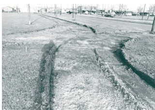
Aanleg fietspad Paganinistraat
